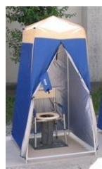
マンホールトイレ
