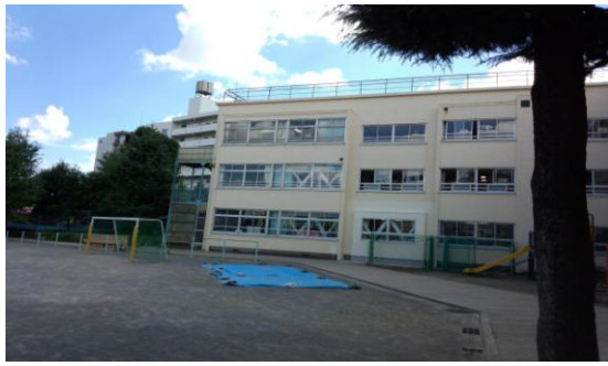
耐震補強された校舎
