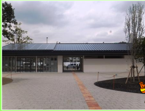
防災機能を備えた管理棟
